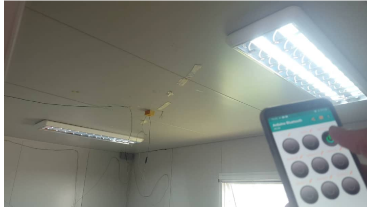
FIGURE III.22 – Commande de l'éclairage de la chambre
