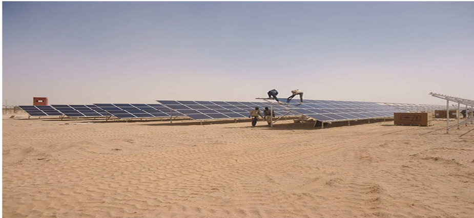
Figure 3 – Installation de la centrale solaire photovoltaïque de 2,16 MW de Adrar.
