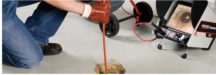
FIG. 1.3 – Fig : Inspection Visuelle à l'aide d'une caméra
