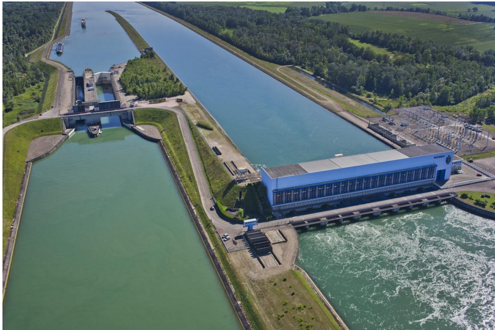
Figure 1.3 Centrale Rhinau sur le Rhin [22]
