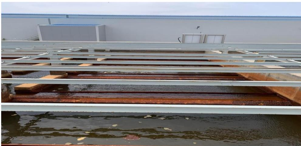
Figure I.15 Filtres à sable
