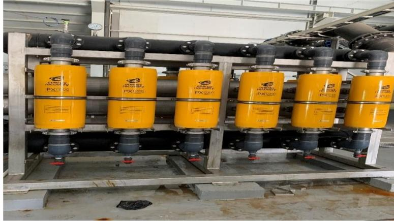
Figure I.21 Système de récupération d'énergie
