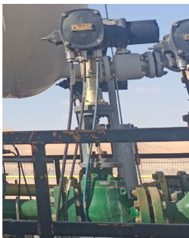
Figure A.17 : Vanne de régulation LV-1001/1002 [25]
