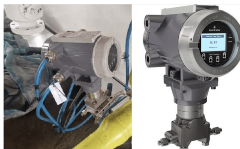
Figure A.11 : transmetteur de débit Emerson FB1100 (FIT-1001) [36]
