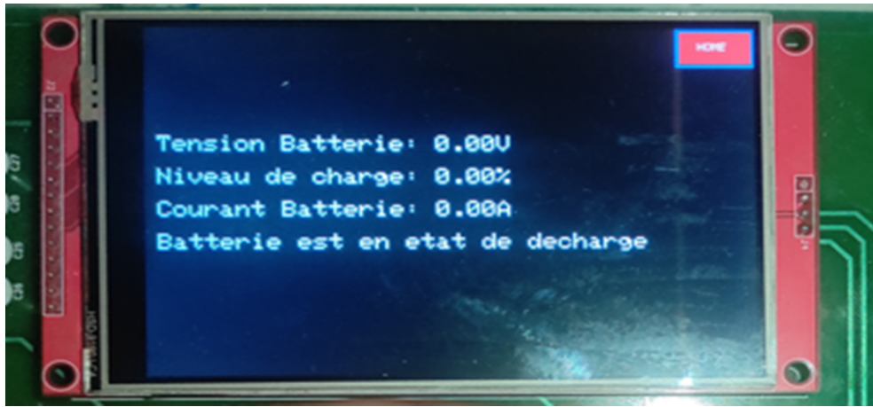
Figure 4.4 : Vue grandeurs électriques coté Batterie d'IHM écran TFT
