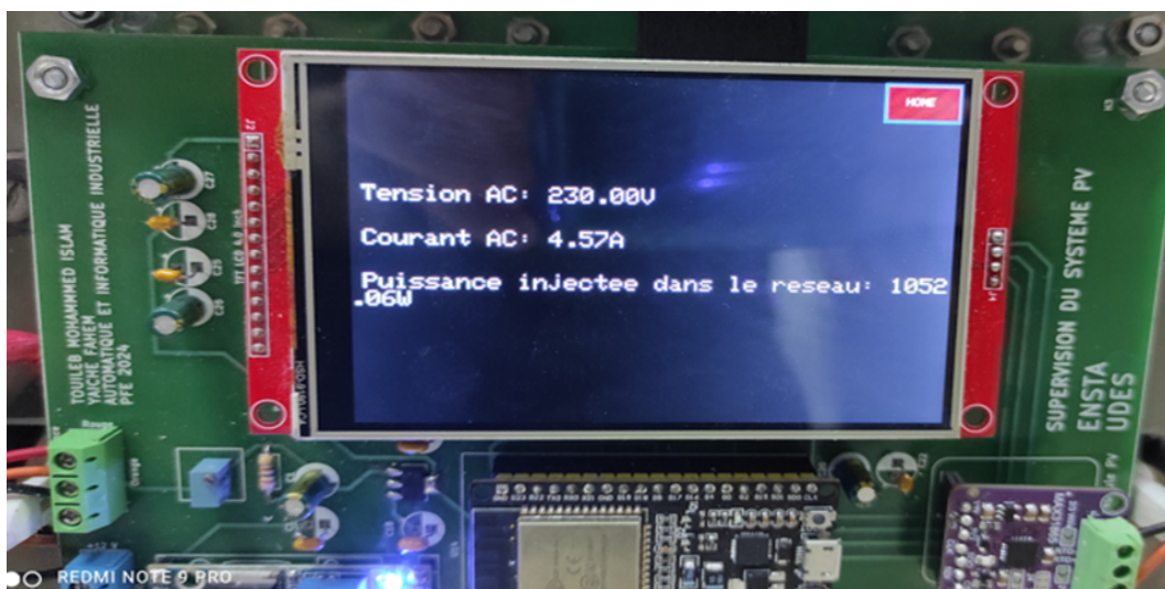
Figure 4.25 : Suivi en temps réel des grandeurs électriques côté AC via l'IHM
