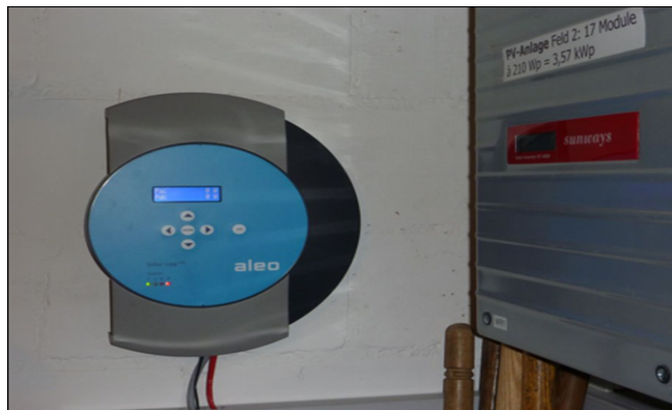
Figure 2.2 : Système de monitoring Solar-Log (solution indépendante connectée à l'onduleur) [22]
