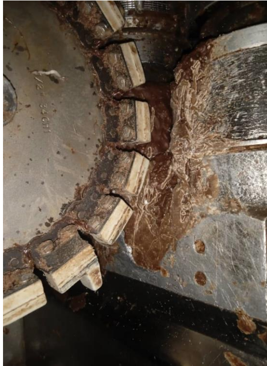
Figure 3.12 : Exemple de source de crasse de la zone située sous l'unité CSL de la FLOWPACK.
