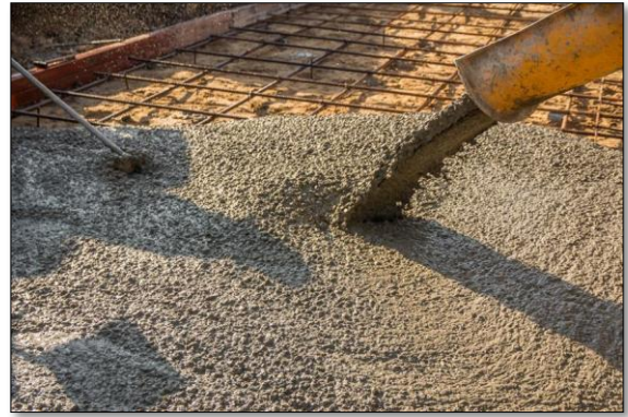
Figure 1-38 Coulage de béton. [53]
