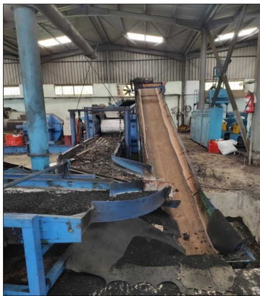
Figure 1-20 Convoyeur de réinjection dans le broyeur.
