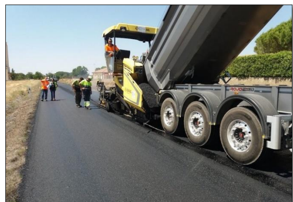
Figure 1-46 Route en asphalte caoutchouté. [44]
