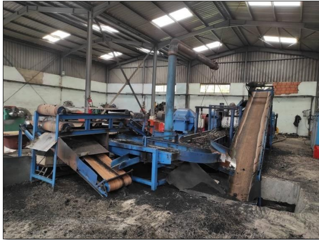
Figure 1-23 Retour des granulés non conformes.
