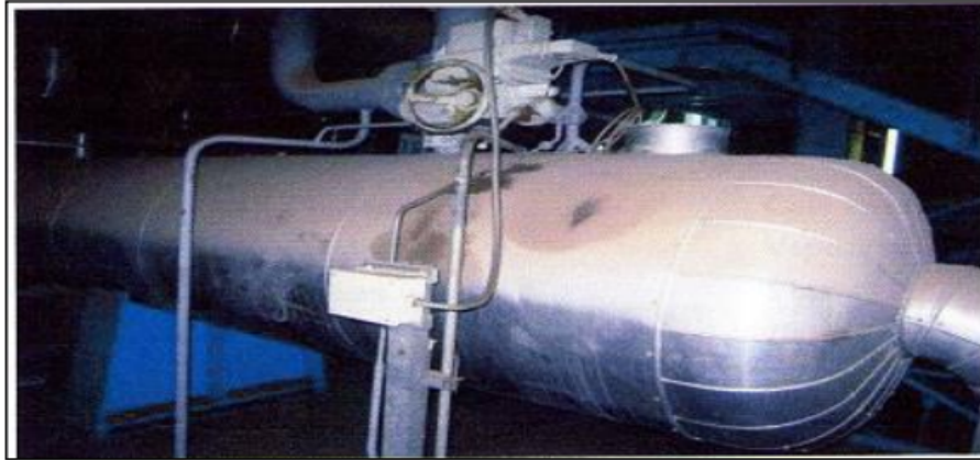
FIG. A.6 : Réchauffeur(Vue de face).
